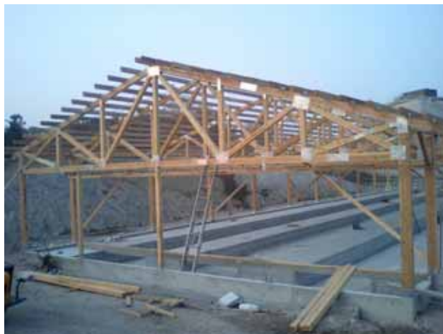
PKP 金具によるトラス構造
