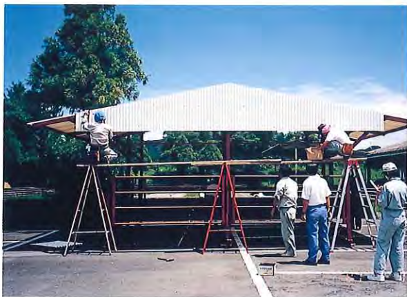
壁はり作業中 (作業開始から約2時間30分)
