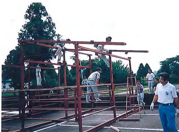
屋根部分の骨組み作業中 (作業開始から約1時間)
